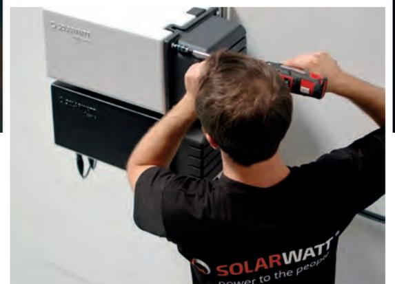
Aufgrund der kompakten Bauweise und des modularen Aufbaus reicht ein Handwerker aus, um den Batteriespeicher zu installieren.
